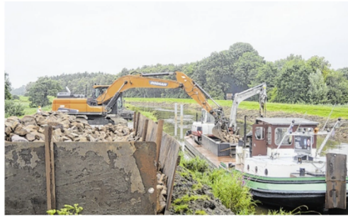
Die angelieferten Schüttsteine lädt ein großer Bagger auf ein Schiff um.
