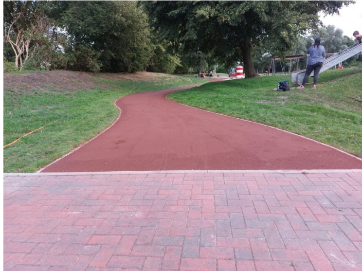
Der neue Fußweg aus Richtung Sanitärgebäude Photo: Gemeinde Ostrhauderfehn
