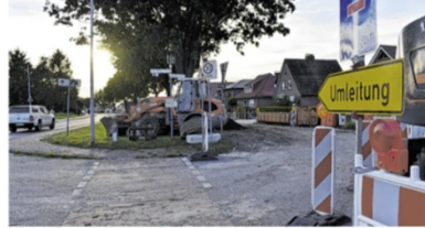
An der Einmündung zur Werftstraße haben in Ostrhauderfehn die Bauarbeiten zum Umbau der Hauptstraßen-Nebenstrecke zu einer Fahrradstraße begonnen. FOTO: ZEIN
