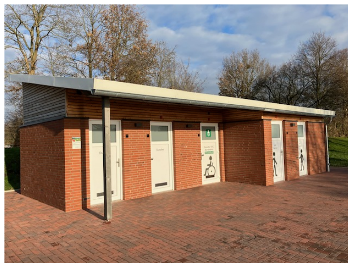
Sanitärgebäude am Idasee Photo: Gemeinde Ostrhauderfehn
