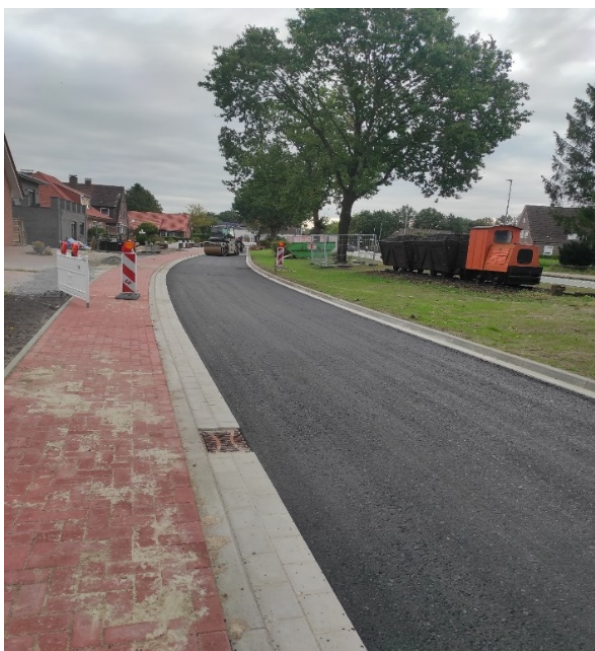
Arbeiten am 1. Bauabschnitt der Hauptstraße-Nordseite Photo: Gemeinde Ostrhauderfehn
