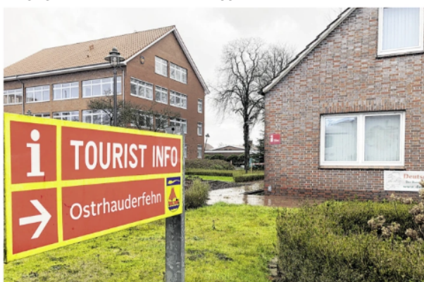
Das Gebäude der Tourist-Information in Ostrhaudefehn (rechts im Bild) soll zurückgebaut werden. Stattdessen soll dort und auf den Flächen drumherum eine große Grün- und Kommunikationsfläche entstehen.
