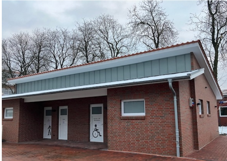
Neues Sanitärgebäude Reisemobilstellplatz Photo: Gemeinde Ostrhauderfehn
