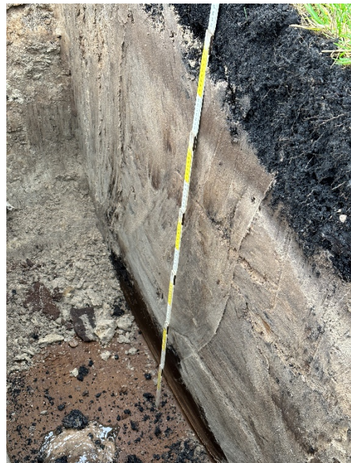
Bild 4: Bodenaufbau im Bereich Schurf S5
