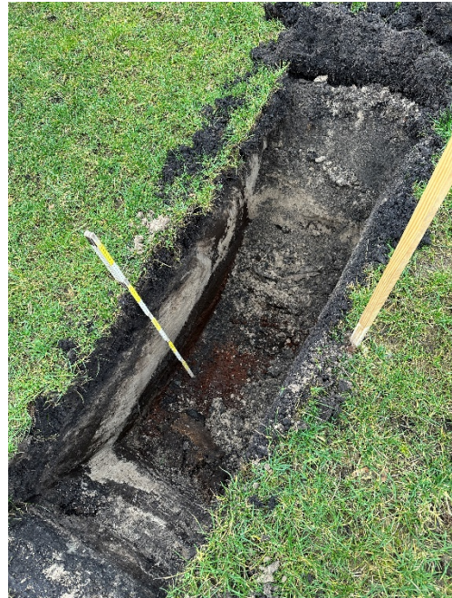
Bild 2: Bodenaufbau im Bereich Schurf S2
