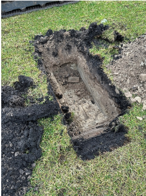
Bild 1: Bodenaufbau im Bereich Schurf S1
