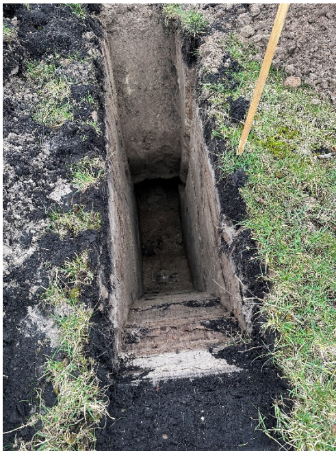
Bild 3: Bodenaufbau im Bereich Schurf S4
